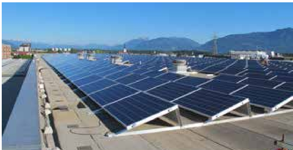
Slika 1: Objekt je večinoma zgrajen iz betona, tako da sama konstrukcija objekta ne predstavlja velike požarne obremenitve.
